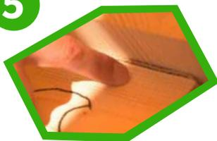
Nach dem Zusammenbau dürfen zwischen Dach und umliegenden Bauteilen keine Spalten bleiben, denn Fledermäuse mögen keinen Durchzug. Für Abhilfe sorgt beispielsweise Sisalband.
